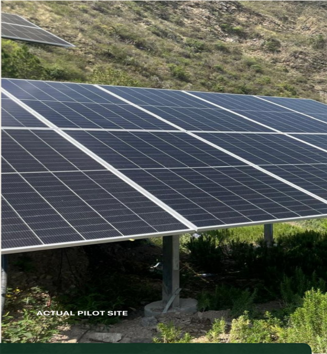
ACTUAL PILOT SITE
